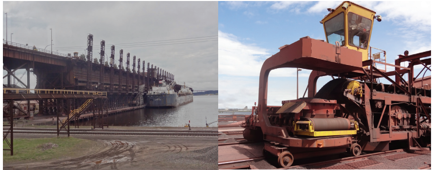
Fig. 2: Los transportadores de buques del muelle en Duluth cargan naves de hasta 10000 toneladas por hora (izquierda). Un transportador de lanzadera trasvasa mineral desde el lugar de almacenamiento en tierra hasta 60 tolvas en el muelle; el detalle del extremo occidental del transportador de lanzadera (derecha) muestra las Poleas Motorizadas Rulmecca de 180 caballos de fuerza (unos 135 kilovatios) descargando material en la tolva norte mediante la pluma articulada.
