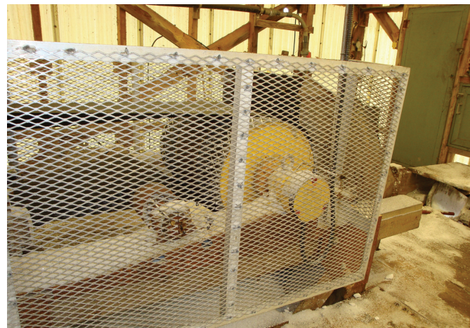
Fig. 5: Gracias al reemplazo del sistema de transmisión original por unas Poleas Motorizadas Rulmecca de 60 caballos de fuerza potencia (unos 45 kilovatios), Cargill eliminó todos los componentes expuestos.
